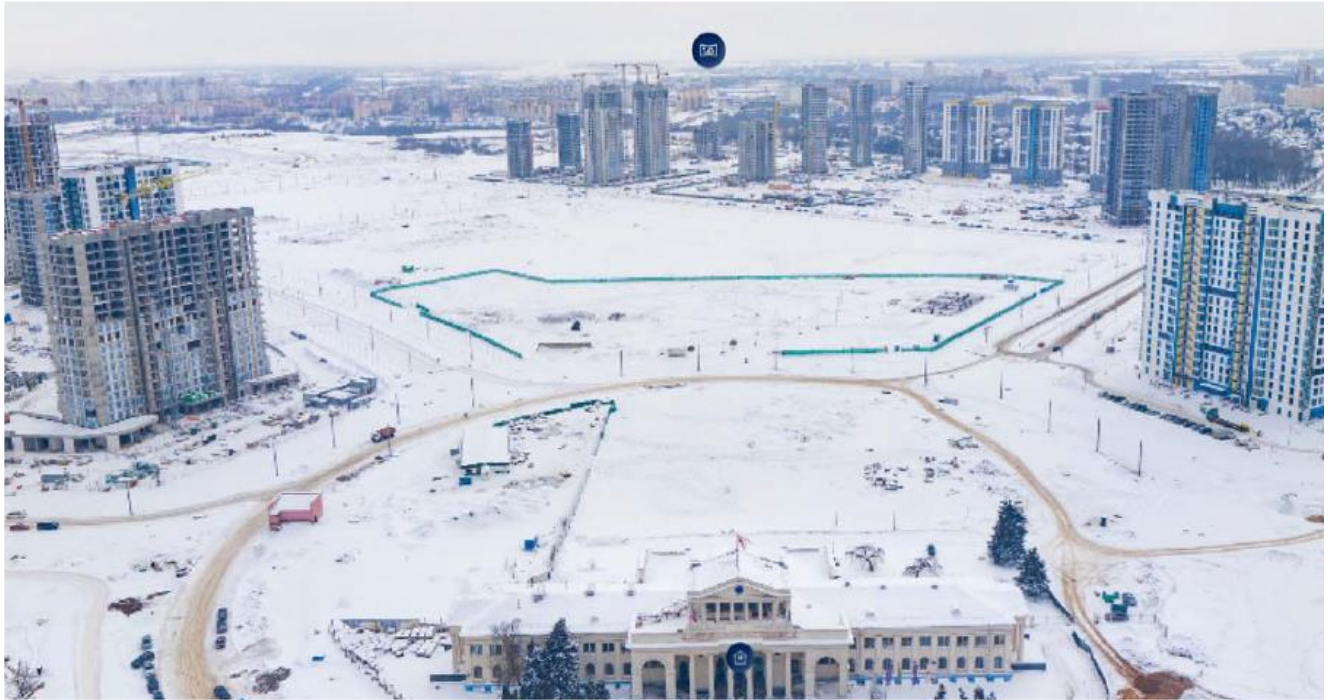
Рисунок 3 - Фото территории строительства (территория, прилегающая к зданию аэропорта)
