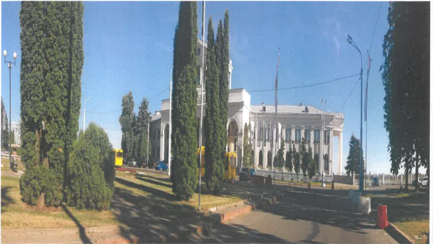
Рисунок 4 – Фото территории строительства (территория, прилегающая к зданию аэропорта, вид спереди)
