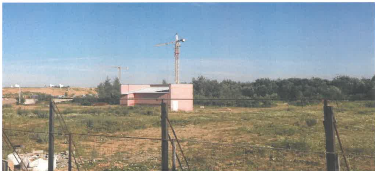
Рисунок 19 – Фото территории строительства (отдельный участок).
