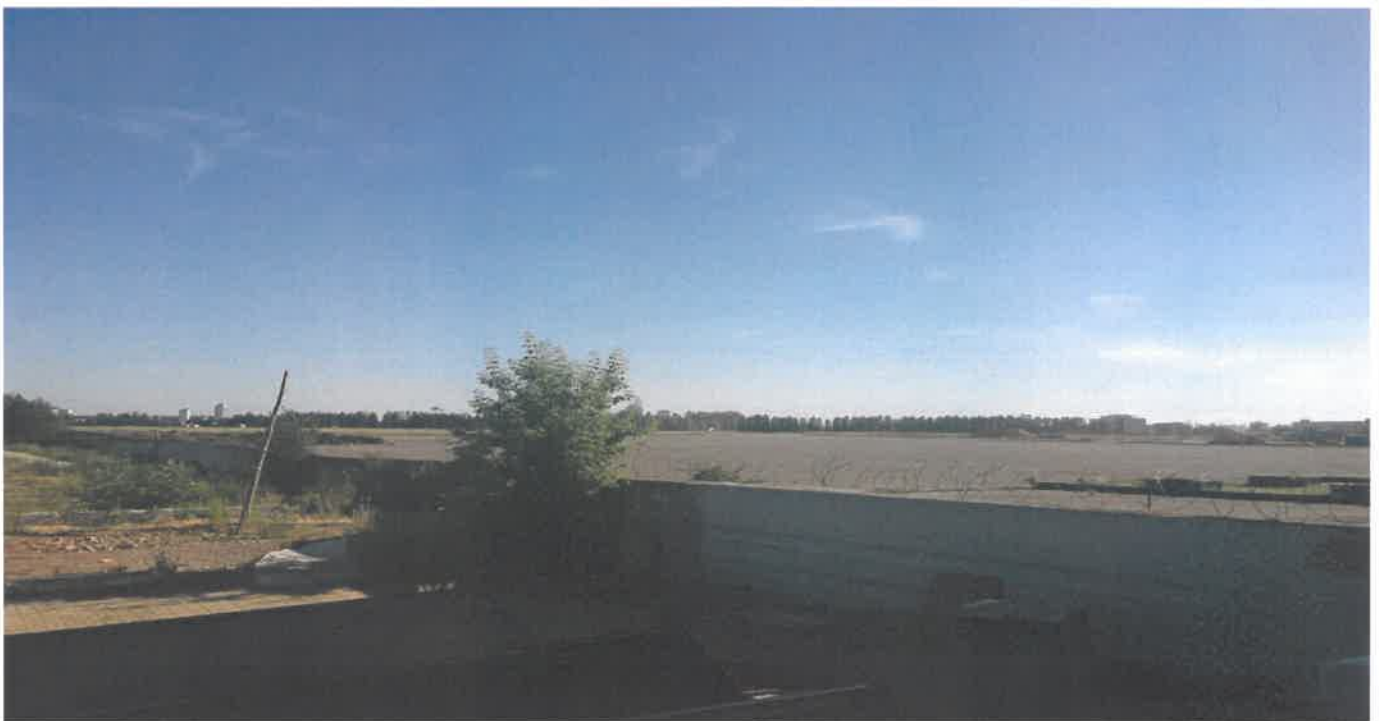
Рисунок 5 – Фото территории строительства (территория, прилегающая к зданию аэропорта, вид позади здания справа)
