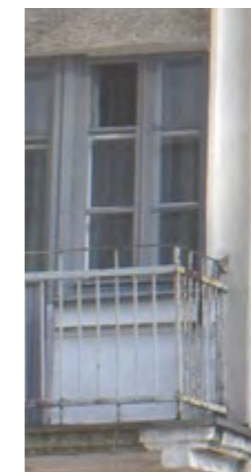
Сохранившиеся аутентичные заполнения оконных и балконных проемов
