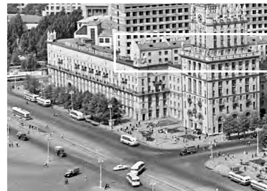
Ул.Ленинградская (фрагмент дворового фасада) - 1967 г.
