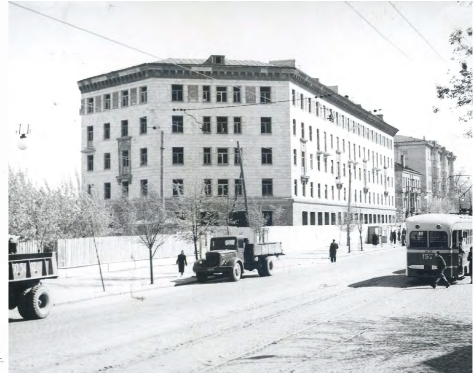
Строительство жилого дома по ул.Московская 9, 1955 - 1956гг.
