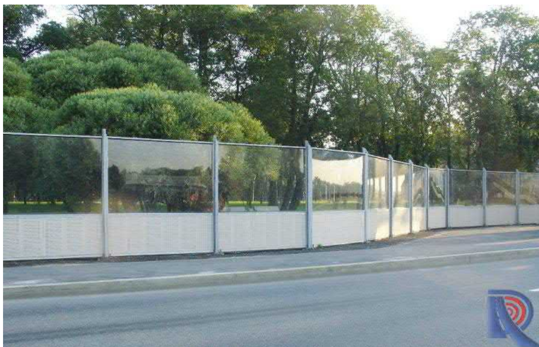
Рис. 8.2. Шумозащитный экран озелененной территории на Приморском пр., Санкт-Петербург, Россия ( http://www.zac-spb.ru )
