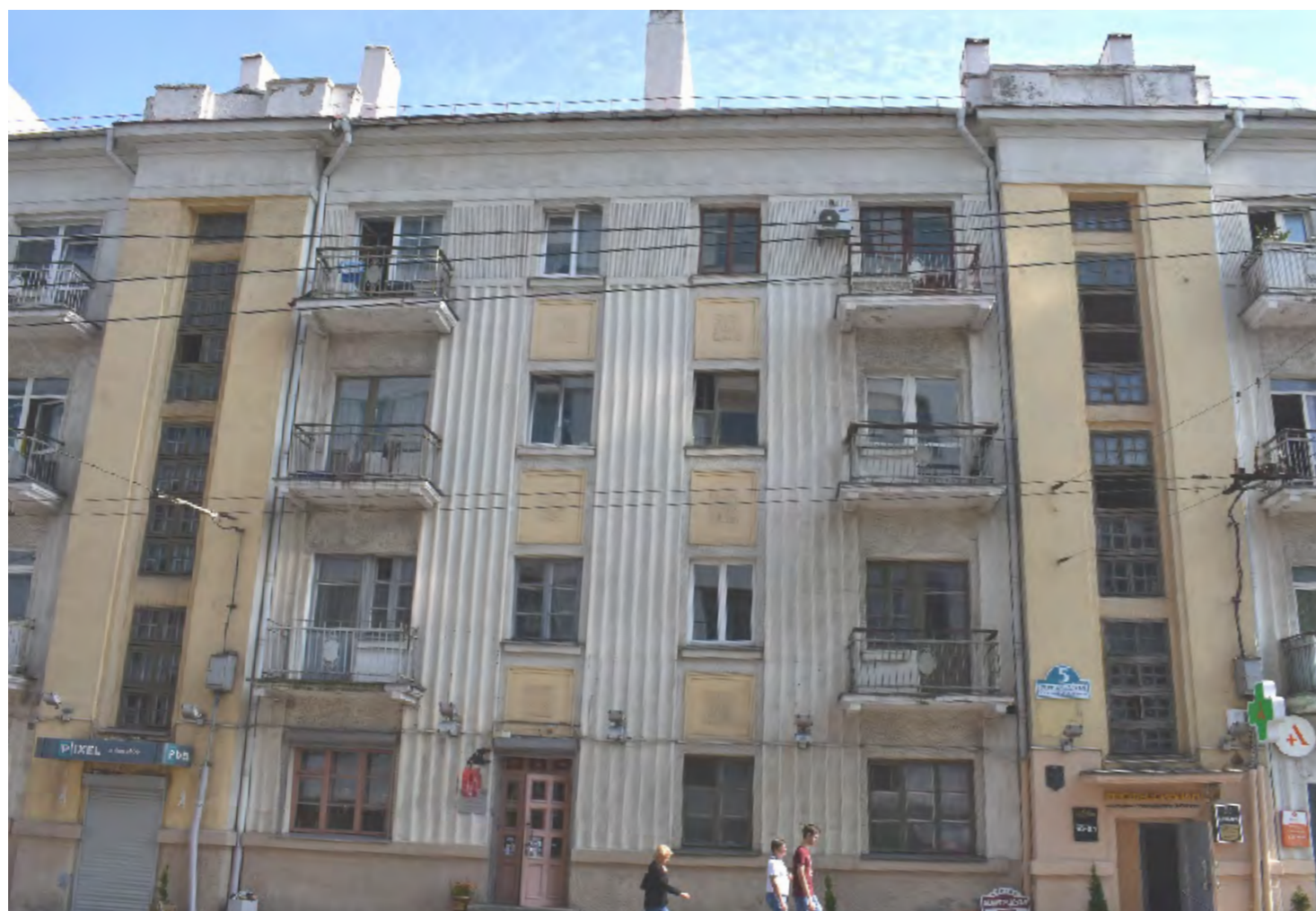
Фрагмент главного фасада
