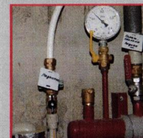
До начала розжига котла открыть линию подпитки системы отопления и контрольную линию заполнения расширительного бака. Убедиться, что давление по манометру, установленному на котле, не растет.
