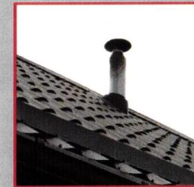
Провести осмотр оголовков дымовых труб и каналов дымоходов и убедиться в отсутствии их обмерзания и закупорки.
