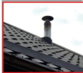
Провести осмотр оголовков дымовых труб и каналов дымоходов и убедиться в отсутствии их обмерзания и закупорки.
