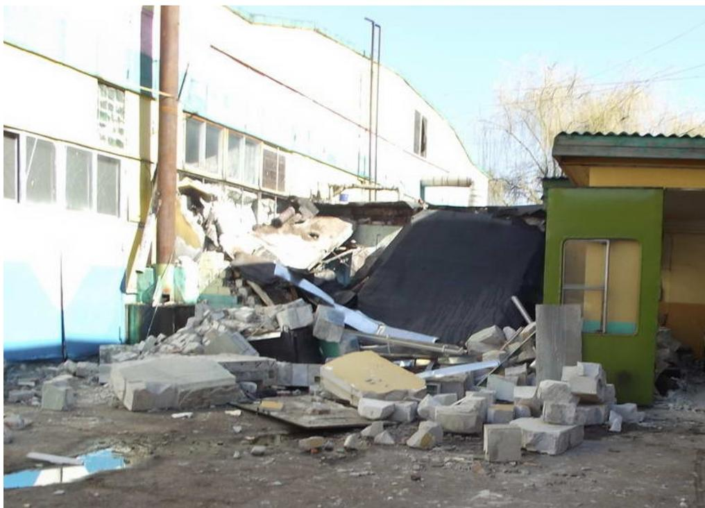
9). 27.03.2016 в мини-котельной (3x8 м), пристроенной к административно-бытовому корпусу ДКУСП «Глубокская ПМК-48» (ул. Озерная, 8, г.п. Подсвилье, Глубокский район, Витебская область) произошел разрыв отопительного котла на твердом топливе. В результате разрыв котла разрушено две стены в мини-котельной, повреждена кровля. Пострадавших нет. Предполагаемая причина разрыва – отсутствие циркуляции воды в системе.
