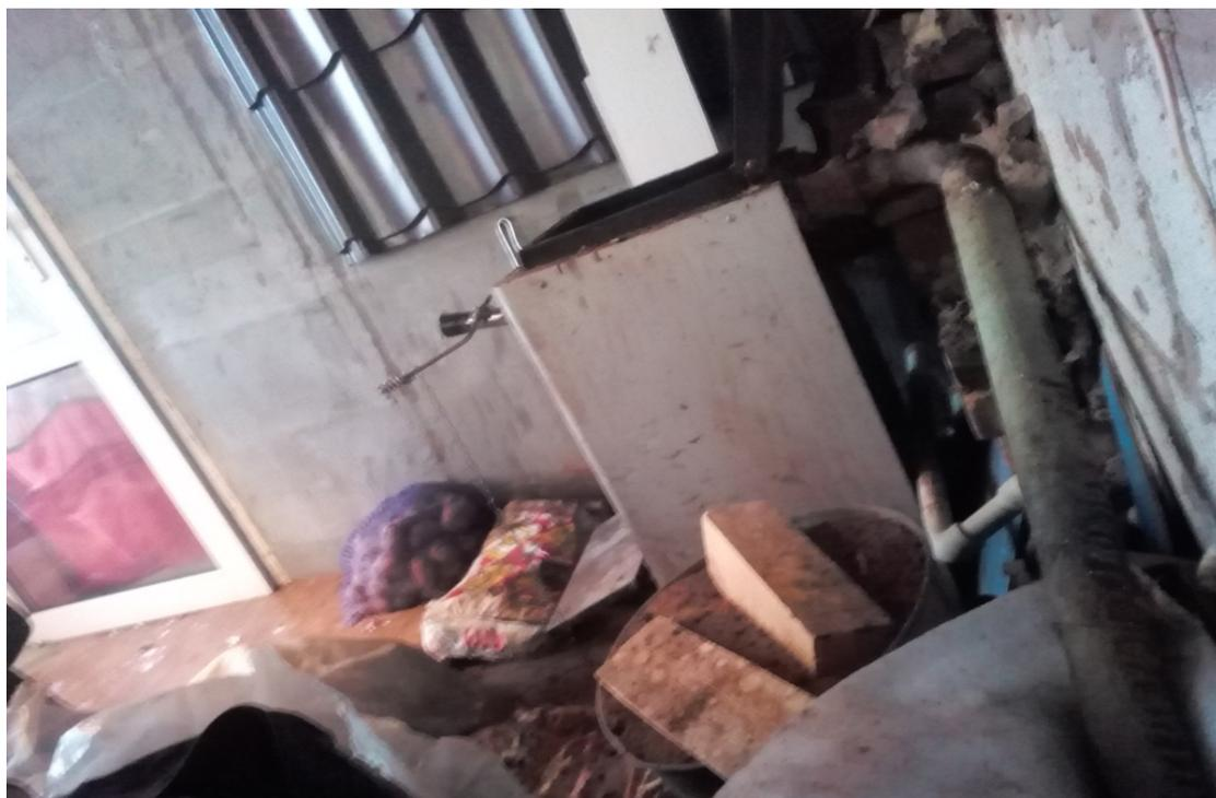
3). 07.01.2016 в помещении мини-котельной (3x4 м) жилого дома (д. Черный лес, Логойский район, Минская обл.) произошел разрыв отопительного котла. В результате разрыва котла пострадал один человек, разрушена стена котельной. Причина разрыва котла – отсутствие циркуляции воды в системе.
