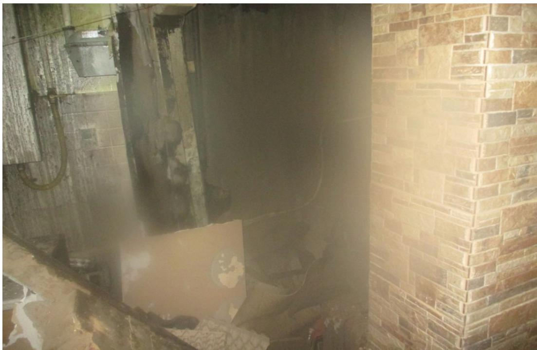
б). 06.02.2016 в помещении кухни (2х3 м) жилого дома (2-й пер. Маличевского, г. Жлобин, Гомельская обл.) произошел разрыв отопительного котла на твердом топливе. Хозяйка жилого дома была госпитализирована с ожогами 1-3 степени (20 % тела). Причина разрыва котла – отсутствие циркуляции воды в системе.
