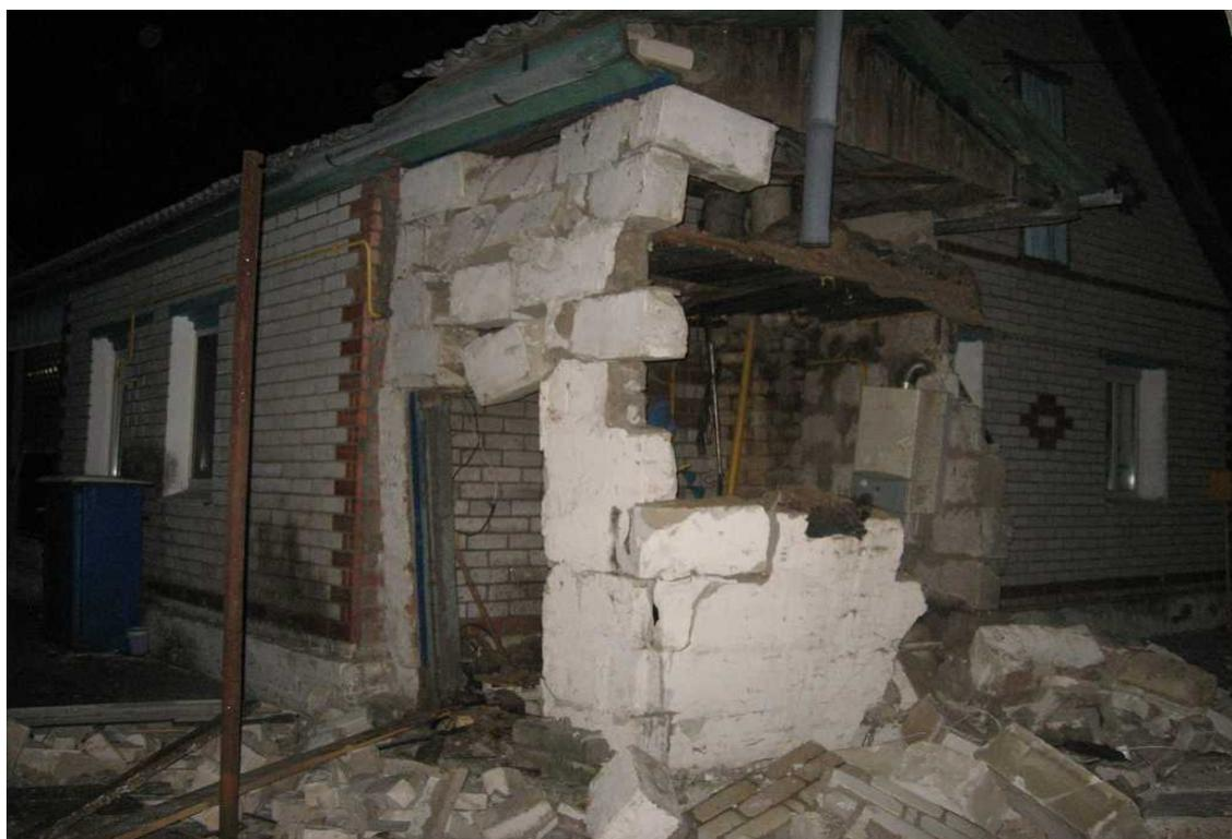
5). 26.01.2016 в помещении мини-котельной (1,2x2 м) жилого дома (ул. Тракторная, г. Могилев) произошел разрыв отопительного котла на твердом топливе. В результате разрыва котла повреждено 4 кв. метра внутренней перегородки котельной жилого дома. Пострадавших нет. Причина разрыва котла – отсутствие циркуляции воды в системе.
