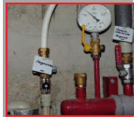
До начала розжига котла открыть линию подпитки системы отопления и контрольную линию заполнения расширительного бака. Убедиться, что давление по манометру, установленному на котле, не растет.
